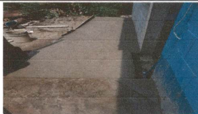
Foto 2: Trabajo de entortado de cemento.
