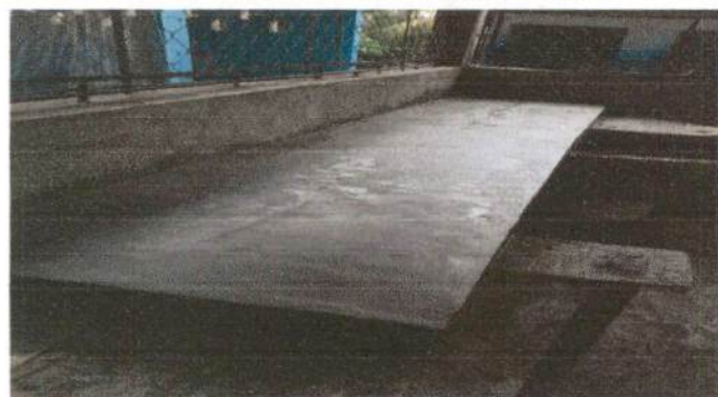
Foto 3: Mesa de concreto para el mejoramiento de cocina del centro educativo.
