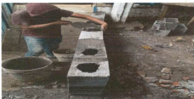
Foto 5: Reparación y levantado de pared en la entrada del centro educativo.
