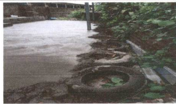
Foto 6: Reparación y entortado de concreto.
